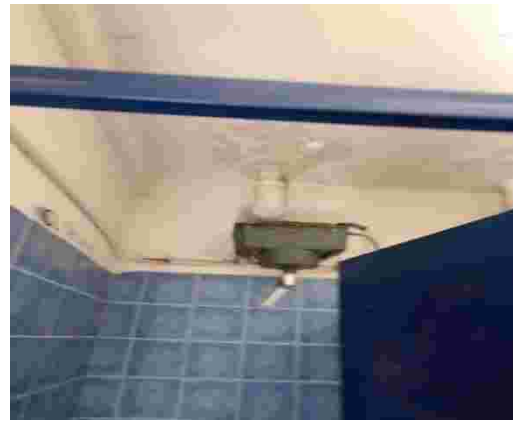
Εικ.2 Καζανάκια παλαιάς τεχνολογίας με δυσεύρετα ανταλλακτικά συντήρησης, όπως πληροφορηθήκαμε επίσης από τα συνεργεία συντήρησης του δήμου .
