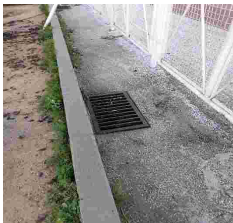
Εικ. 26 Ενδεικτική εικόνα φρεατίου όμβριών
